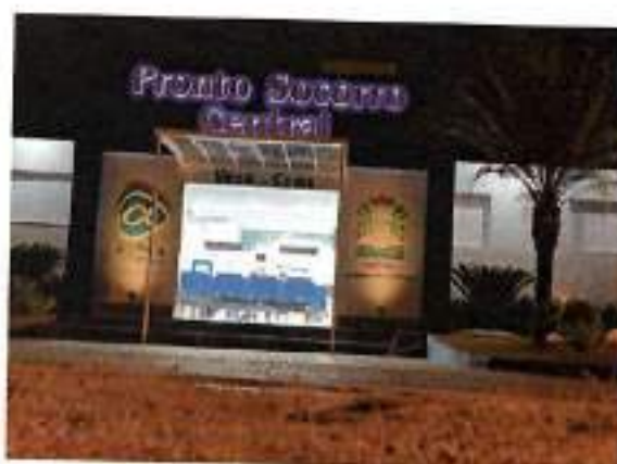
ILUMINAÇÃO NA FACHADA
